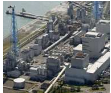
地震の影響で停止した苫東厚真火力発電所（6日、北海道厚真町）
