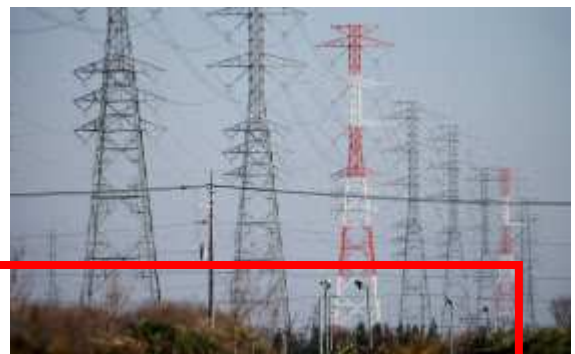
「ブラックアウト」は一つの火力発電所に電力を大きく依存していた北海道電力だけの問題とは言い切れない
